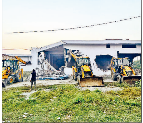
पानीपत। अवैध निर्माण को गिराती डीटीपी की जैसीबी।
